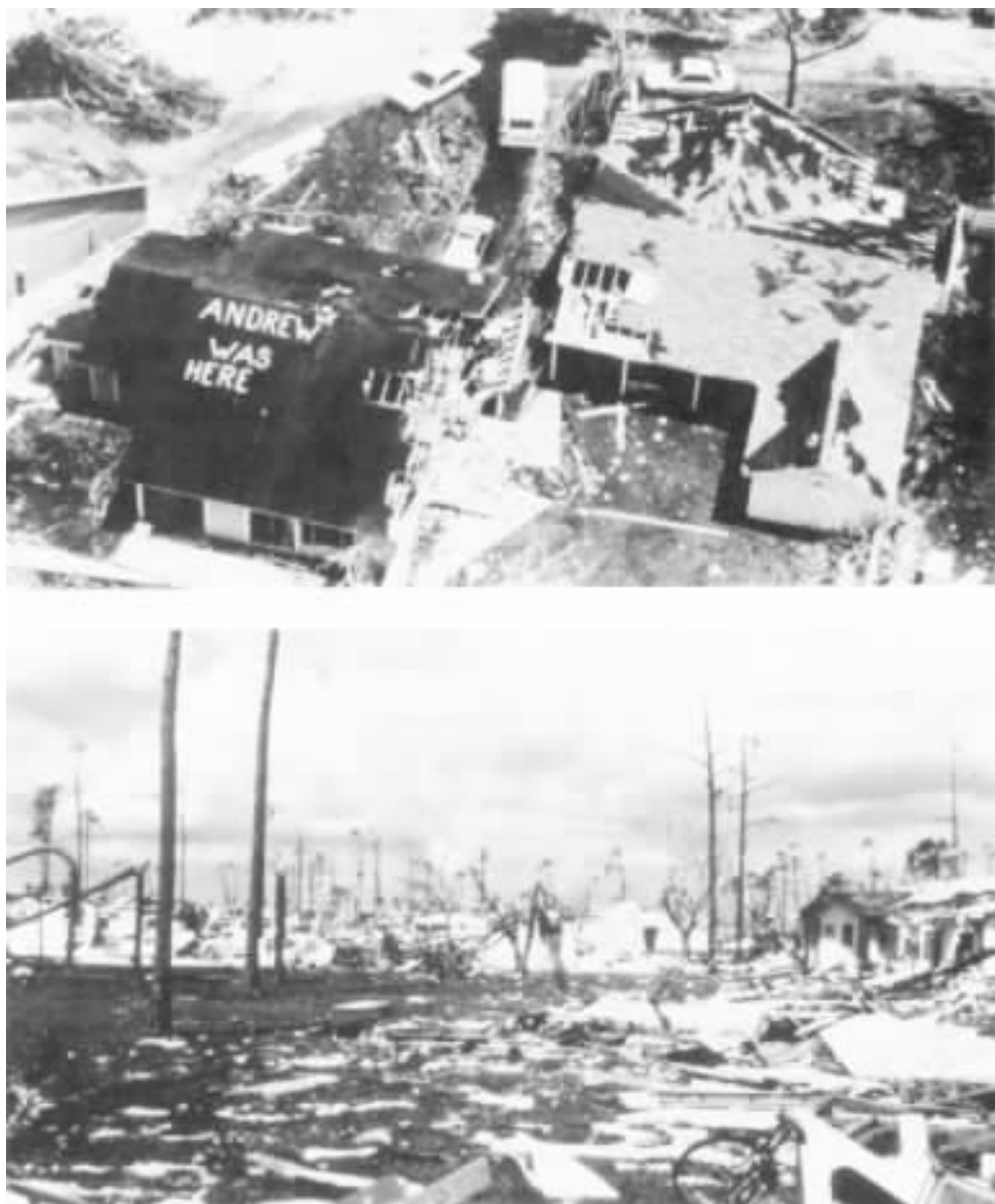
图 3-9 1992 年 8 月安德鲁飓风造成的损失
