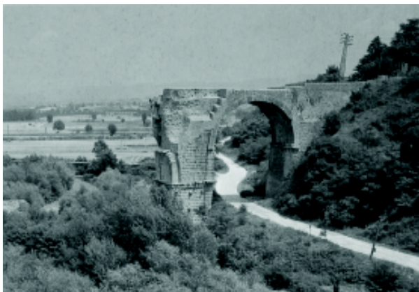
南尼大桥实景
