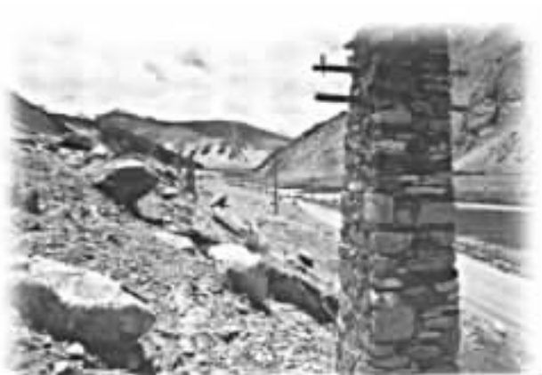
后藏地区特有的石砌电线柱子
